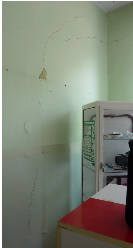
Nr66 – rysa szer. <2\text{mm} , dł. L\sim 3,3\text{m}
