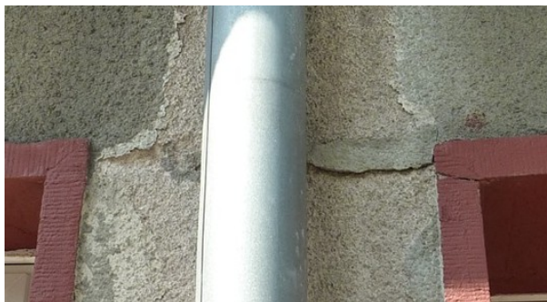
Nr21 – rysa szer. <2mm, dł. L≈~0,5m
