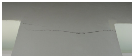
Nr68 – rysa szer. <1\text{mm} , dł. L\sim 0,6\text{m}
