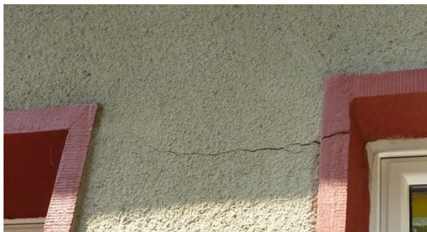
Nr21 – rysa szer. <2mm, dł. L≈~0,5m
