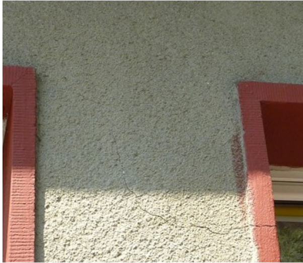
Nr20 – rysa szer. <1mm, dł. L≈~0,5m
